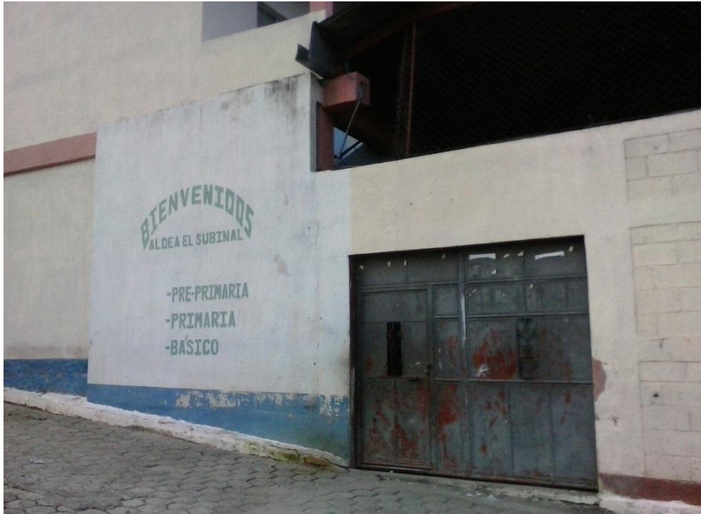
Imagen 3. Fotografía en INEB El Subinal, Guastatoya
