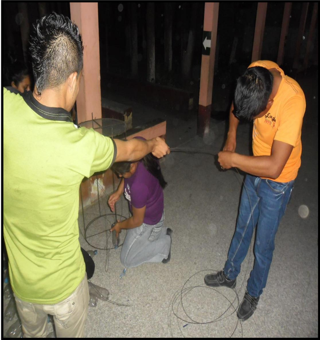
Se seccionó el alambre de amarre galvanizado calibre 16 para la fijación de las botellas plásticas ya perforadas.
