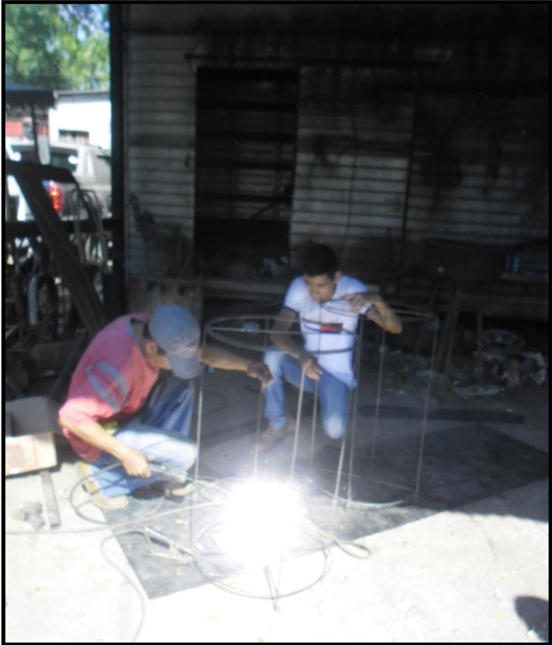
Se soldaron las varillas de  $\frac{1}{4}$  para la formación de la estructura de los Depósitos para basura.
