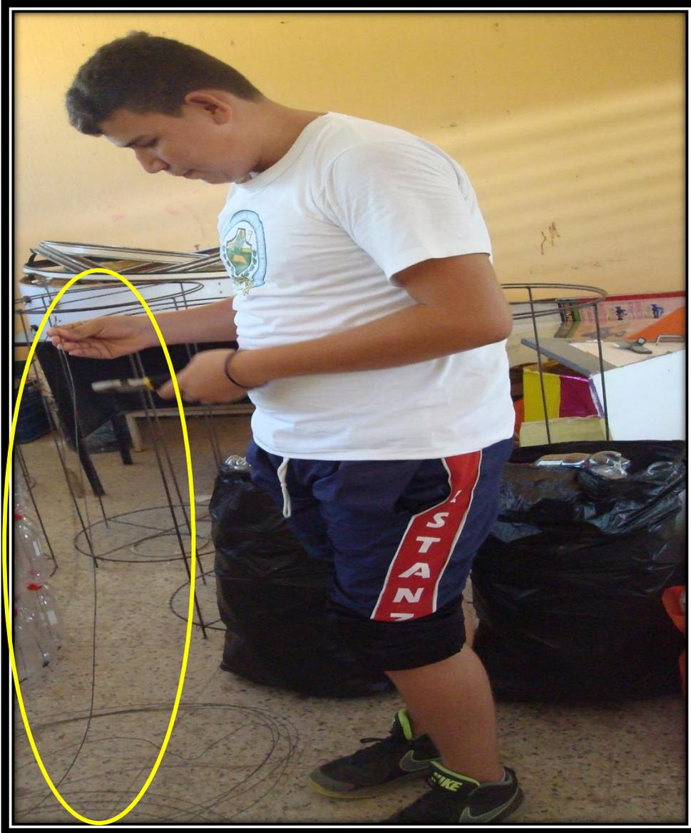
Se finaliza la elaboración de los depósitos para basura, asegurando las botellas plásticas a la estructura metálica con ayuda del alambre de amarre.
