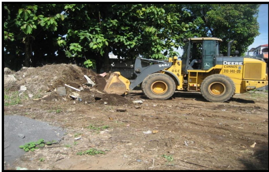
La máquina sacando los volcanes de tierra, de la Zona Vial 4 de caminos de Retalhuleu.
