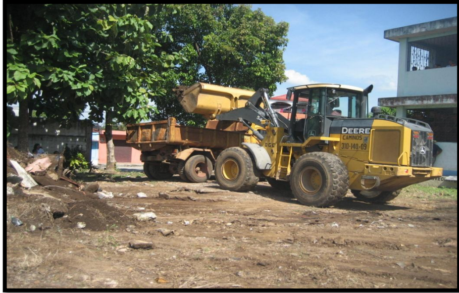
Este el momento cuando se está llenando los caminos de volteo, de la Zona Vial 4 de caminos de Retalhuleu.
