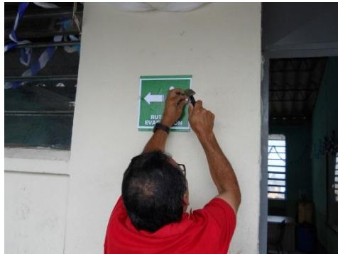
Colocación de señales de rutas de evacuación
