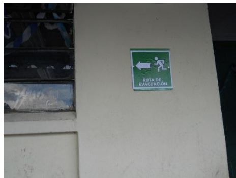
Señalización de rutas de evacuación (pasillo)
