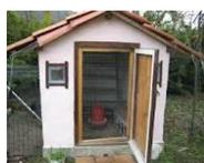
**e) Instalación de la puerta.** La puerta debe abrir hacia el exterior, y ser lo suficientemente ancha como para entrar con una carretilla, lo que nos facilitará el transporte de alimento, agua y la recogida de la gallinaza.
