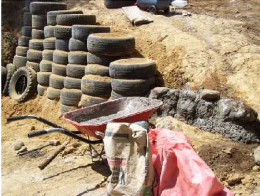
Construcción del muro de protección con llantas.
