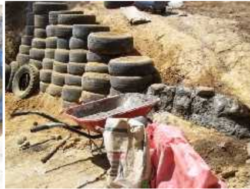
Construcción de muro de protección, con llantas.
