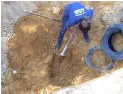
Construcción de muro de protección, con llantas.
