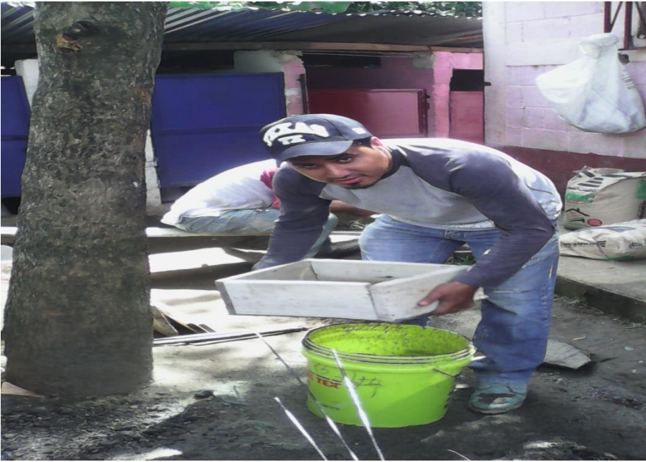
Epesita cerniendo arena para preparar el concreto.
