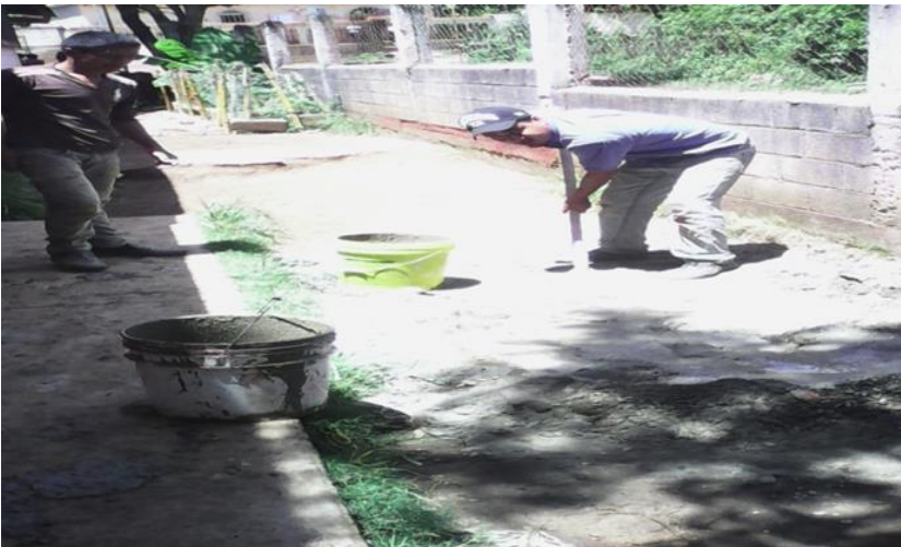
Epesista mesclando el concreto para la fundición de la terraza.
