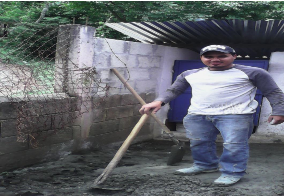
Epesita mesclando el concreto para la fundición.
