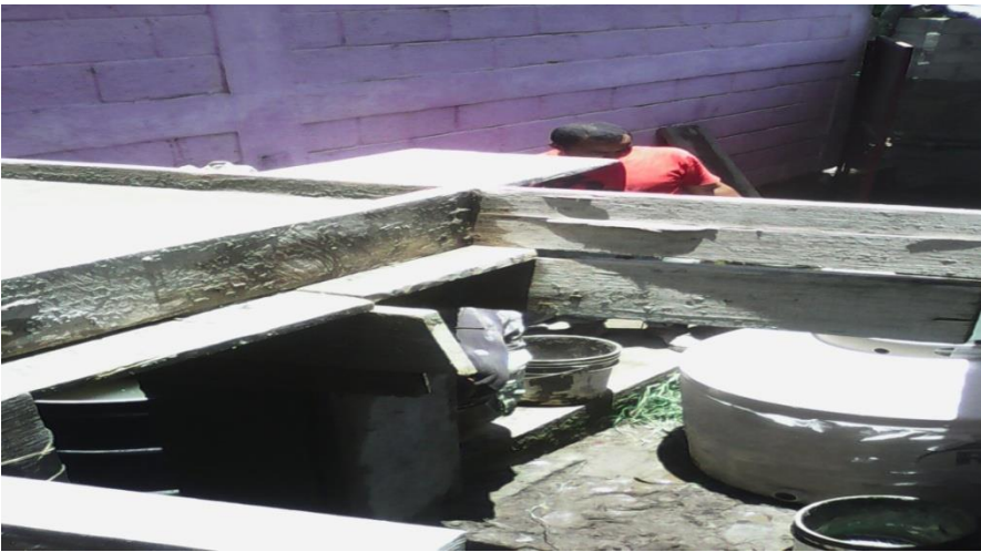
Terraza completamente fundida.
