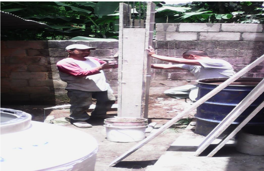
Albañiles colocando el cajón para el soporte de la terraza.
