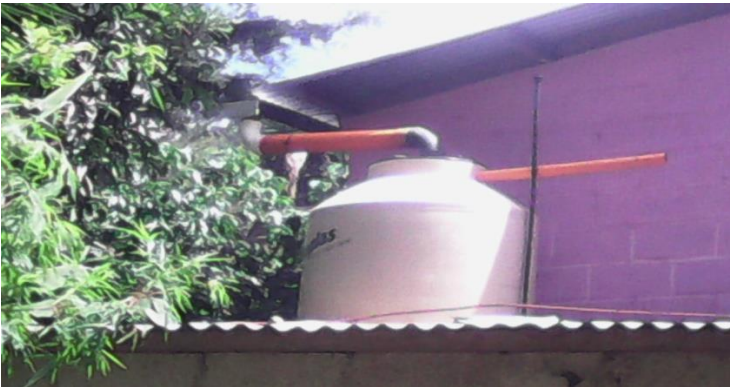
Aljibe colocado correctamente.
