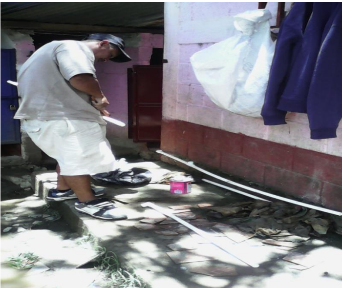
Ayudante de Albañil coloca la tubería para los chorros.
