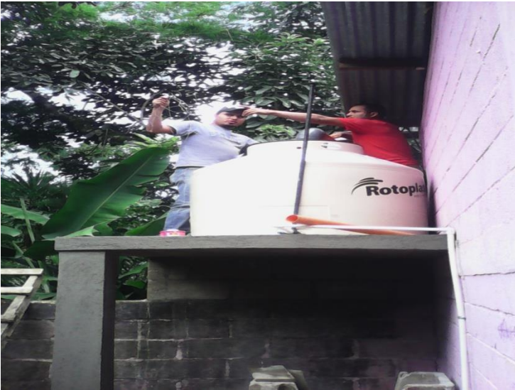
Epesista y albañil terminan de instalar el tinaco
