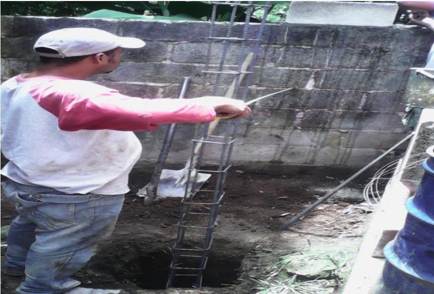
Albañiles tomando las medidas de la terraza para la colocación del tinaco.
