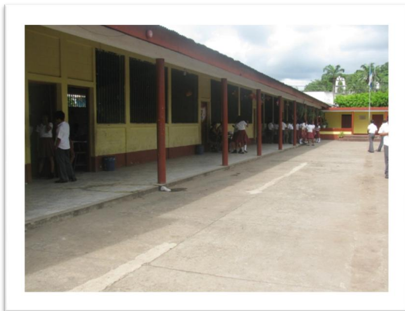
Instalaciones del Instituto Nacional de Educación Diversificada, municipio de Catarina, San Marcos.
