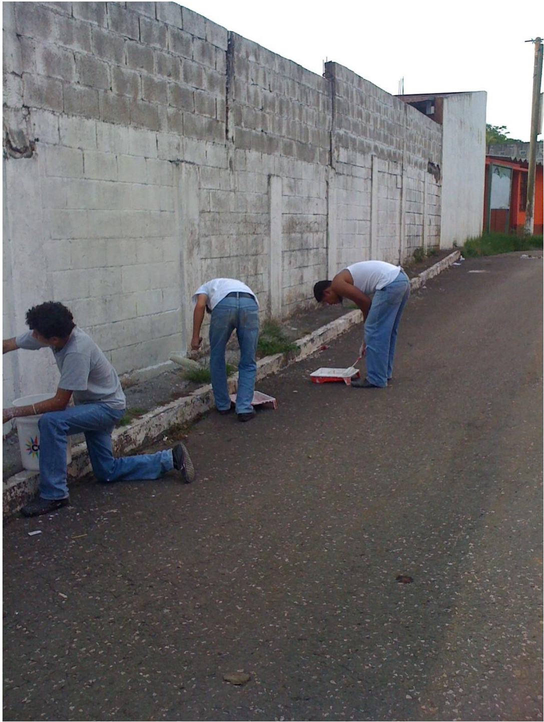
Pintura del muro perimetral en conjunto con alumnos del Establecimiento.
