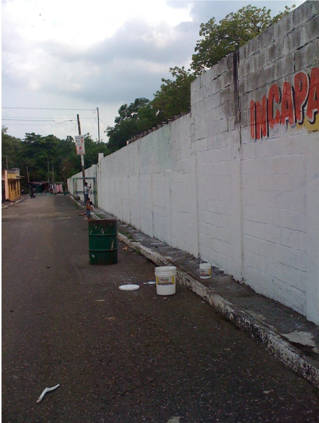
Remozamiento de muro perimetral, Escuela Oficial Urbana Mixta de Colonia Palmeras del Sur, Escuintla.
