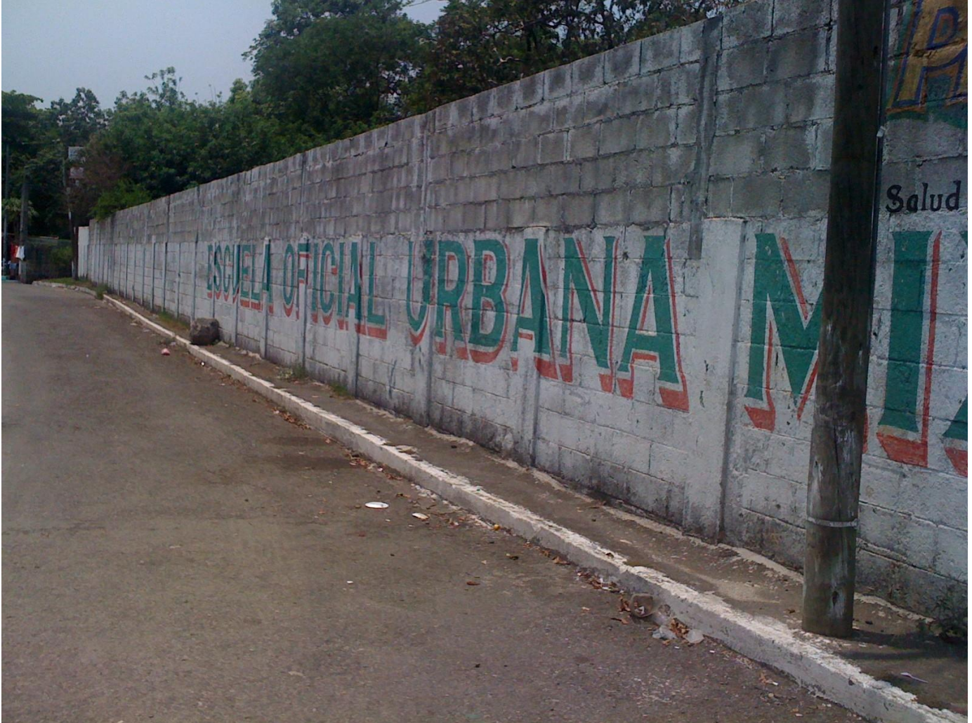
Muro Perimetral de la Escuela Oficial Urbana Mixta de Colonia Palmeras del Sur, Escuintla.
