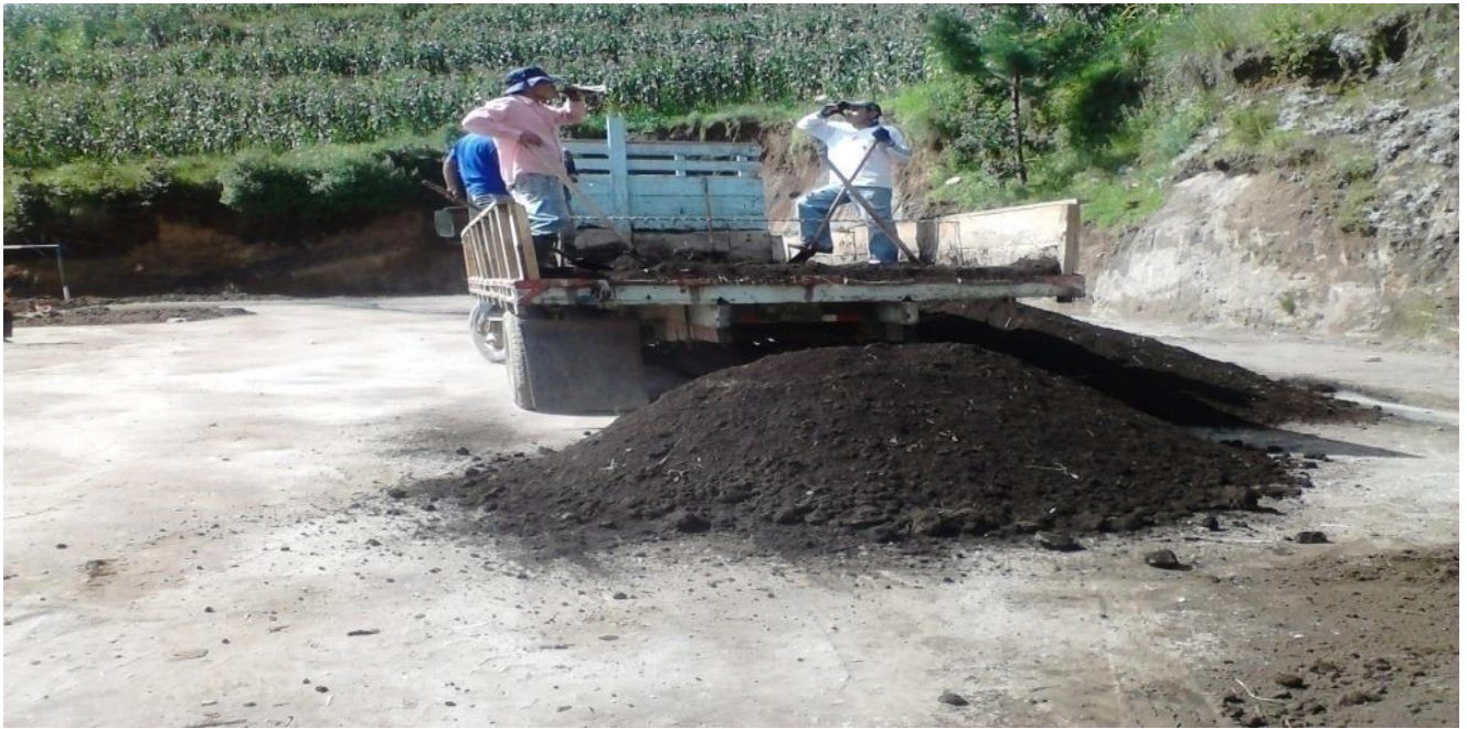
Descarga de tierra negra tipo barrial en el campo de futbol, para colocación de capa del engramillado.
