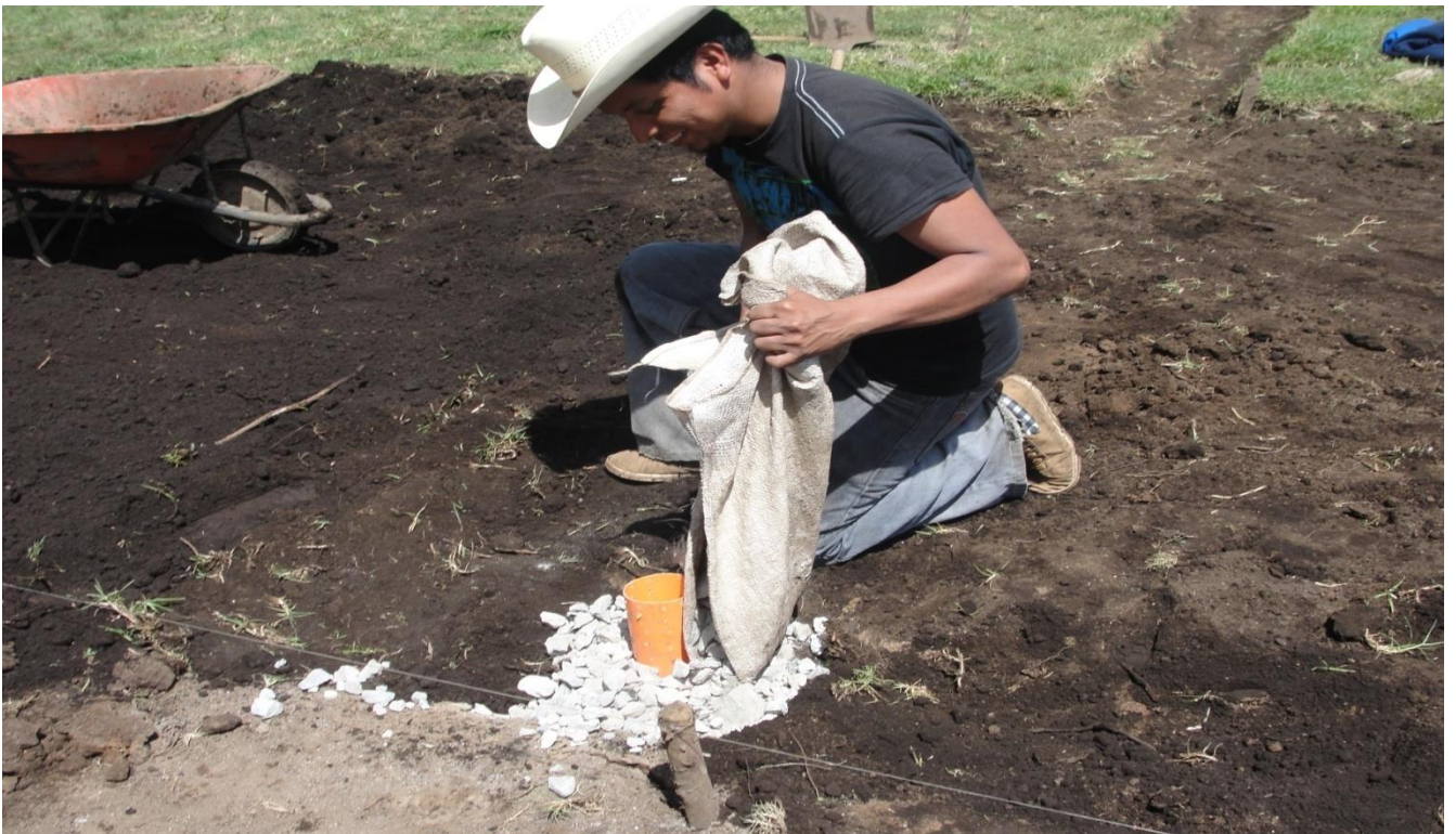
Epesista colaborando en la colocación de tubo PBC para captación de agua en la superficie del engramillado
