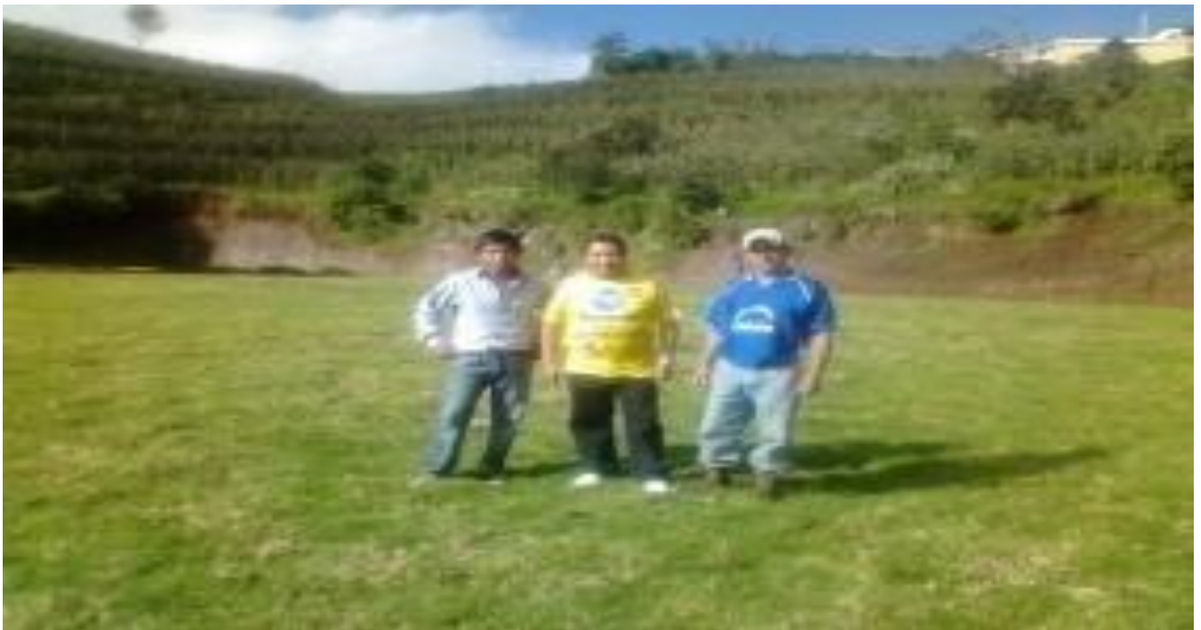
Epesista, alcalde municipal y encargado del proyecto, supervisan el avance de los trabajos.
