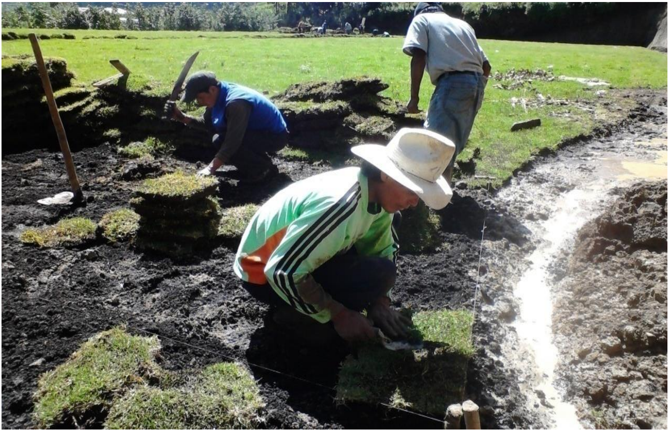
Trabajadores colocando tajas de grama.
