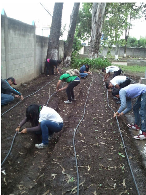
Colocación de tubería para el riego por goteo de los huertos con los estudiantes de cuarto Bachillerato en Construcción
