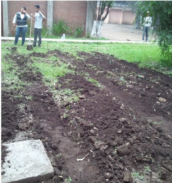
Limpieza del terreno donde se realizaran los huertos con los estudiantes de cuarto Bachillerato en Construcción
