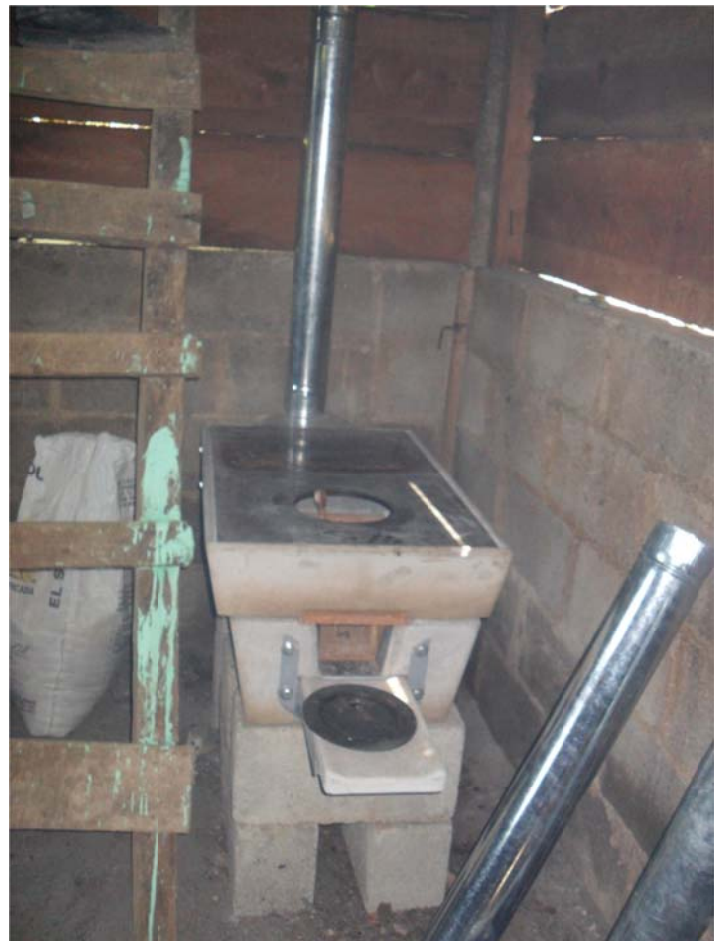
Instalación y construcción de la Estufa Ahorradora de Leña.
