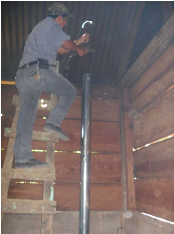
Instalación y construcción de la Estufa Ahorradora de Leña.
