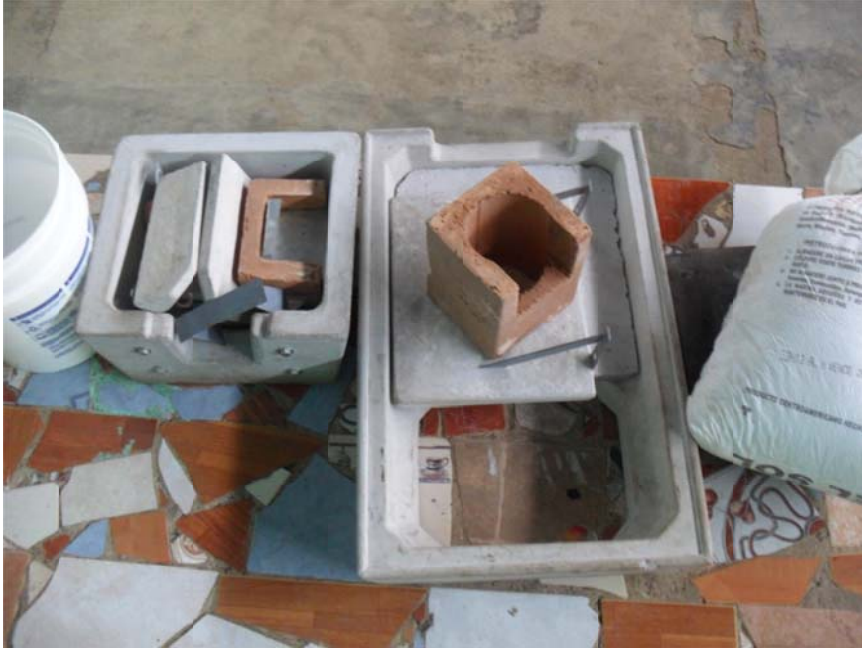
Materiales para la construcción de la estufa ahorradora de leña.
