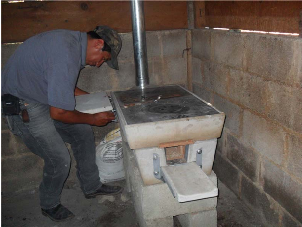
Terminando de Construir la Estufa Ahorrada de Leña.
