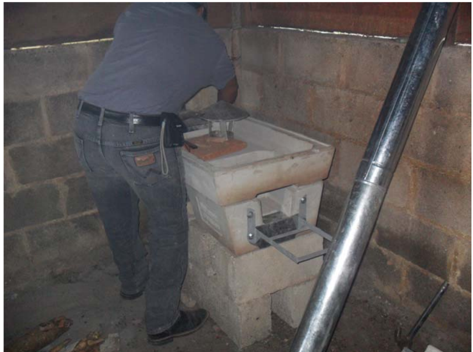
Construcción de Estufa Ahorradora de Leña.
