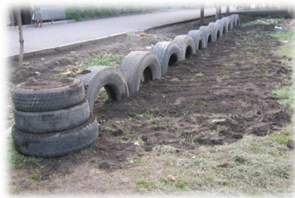
Colocación de material reciclado en área a jardinizar
