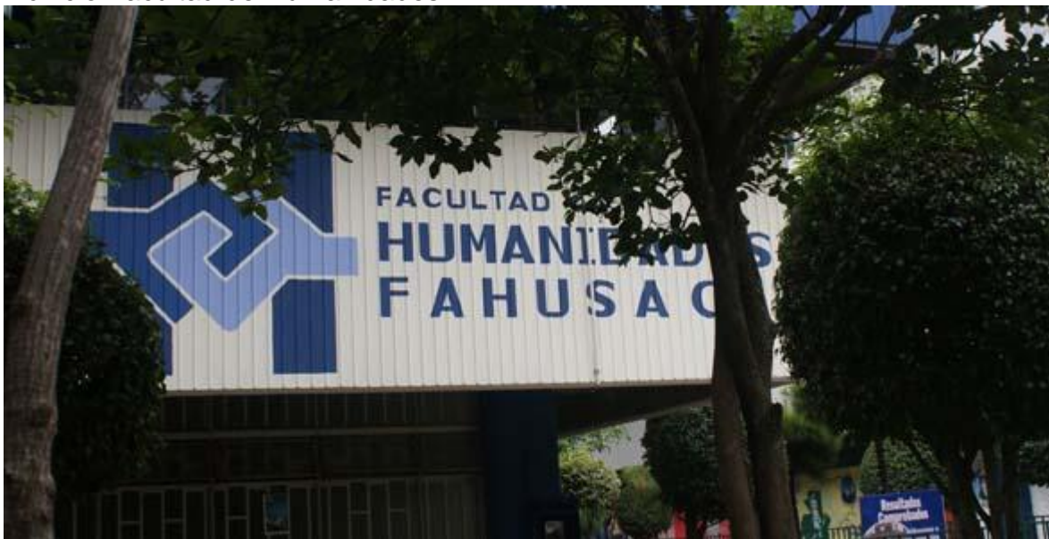
Figura 2. Exterior del Edificio de Facultad de Humanidades de la Universidad de San Carlos de Guatemala. Departamento de Relaciones Públicas, Facultad de Humanidades. Fuente: http://detallesyservicios.com/igatics/?page_id=30
