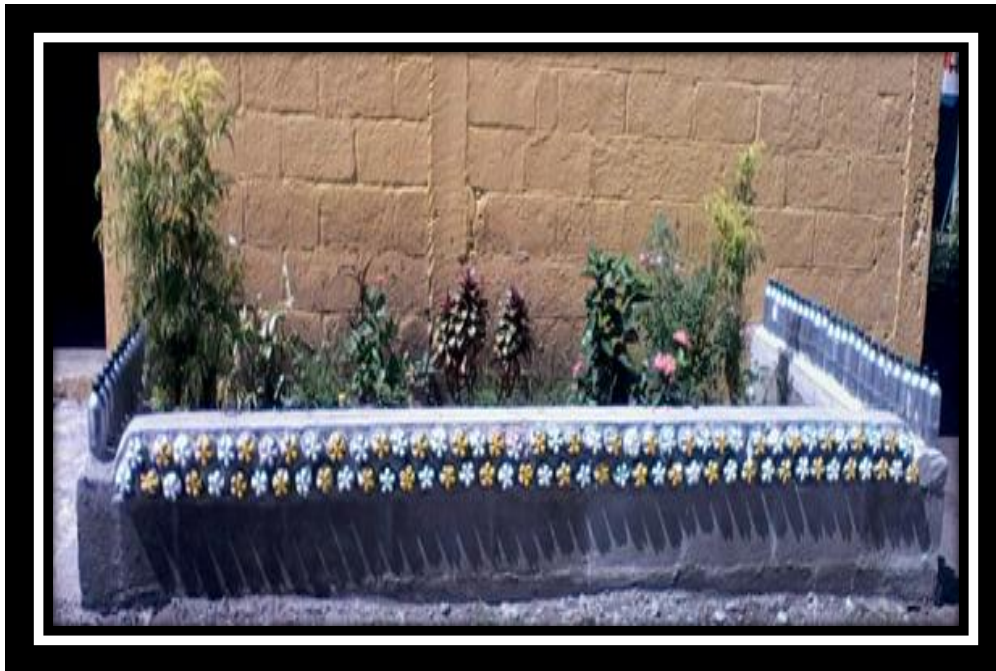
Jardinera terrestre terminada. Se utilizaron envases plásticos de 600 ml.
