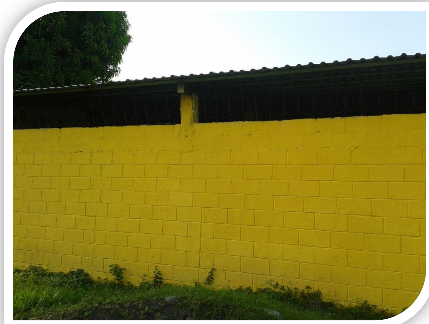
Área a construir las jardineras aéreas, utilizando envases plásticos.
