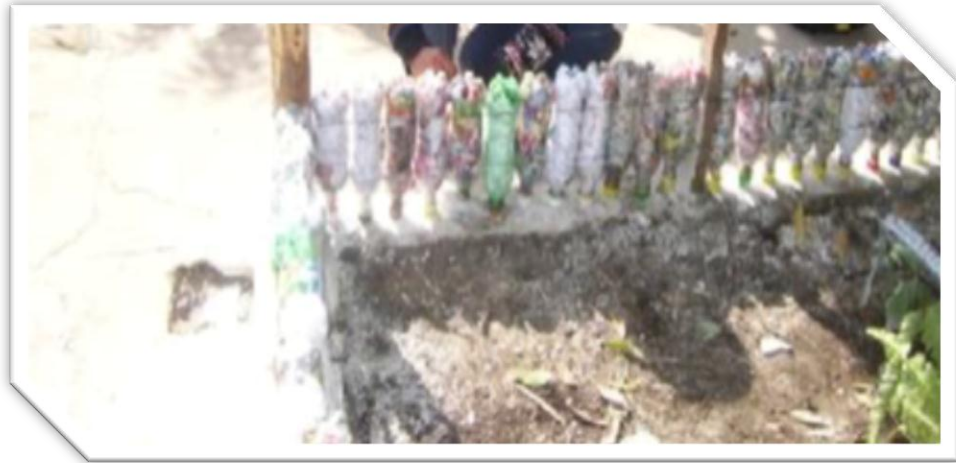
Construyendo jardineras terrestres utilizando envases plásticos
