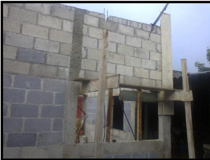
Levantado completo de paredes, terminando de fundir columnas
