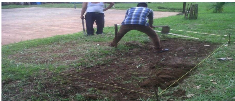
Foto tomada al epesista al momento de limpiar el terreno
