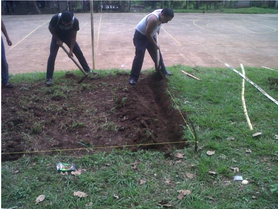
Foto tomada al epesista al momento de zanjar para colocar neumáticos
