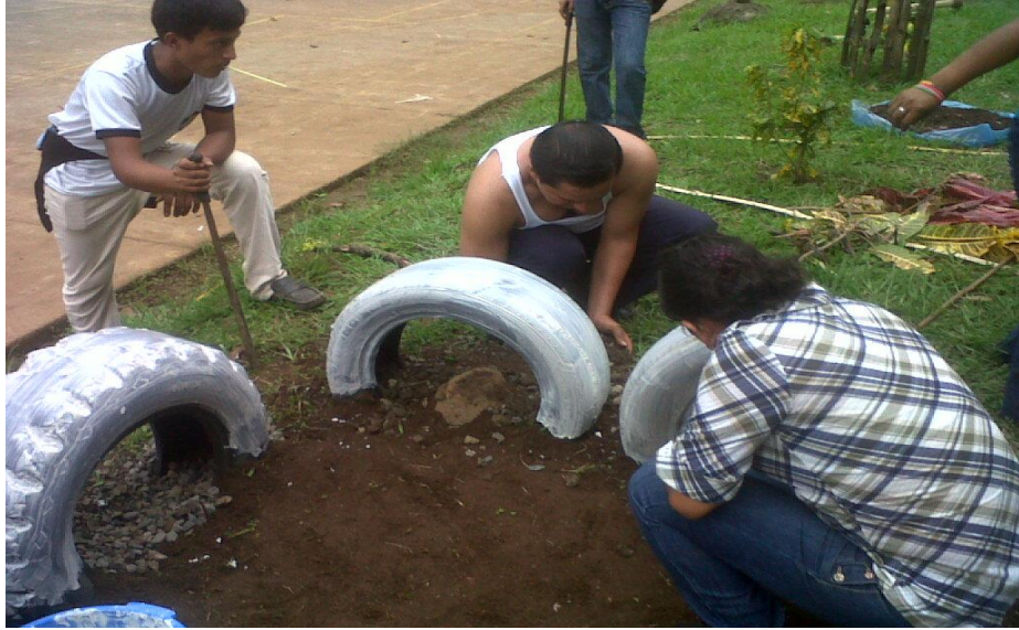
Rellenando los neumáticos con tierra y piedrín para que no sean extraídas
