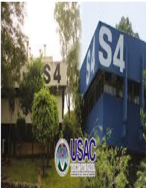
EDIFICIO DE S4
