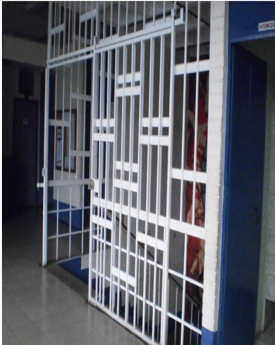
CERRAMIENTO EN GRADAS
