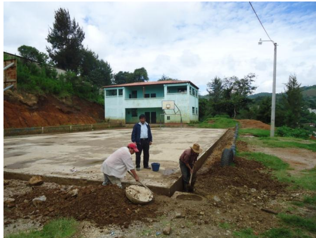
Construcción de cunetas
