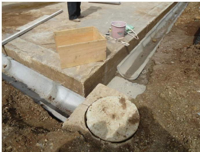
Cunetas ya construidas
