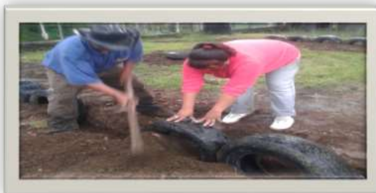
Fuente: Epesista Soraida Pérez Introducción de llantas en la zanja por trabajador municipal
