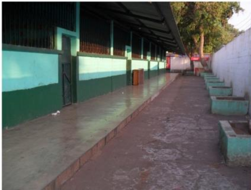
Aulas de Primaria de la Escuela Oficial Urbana Mixta Monterrey.
