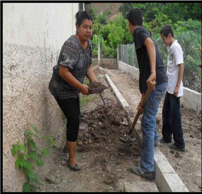
La Epesista quitando escombros de tierra de la parte del costado de arriate para rellenar el terreno del jardín.
