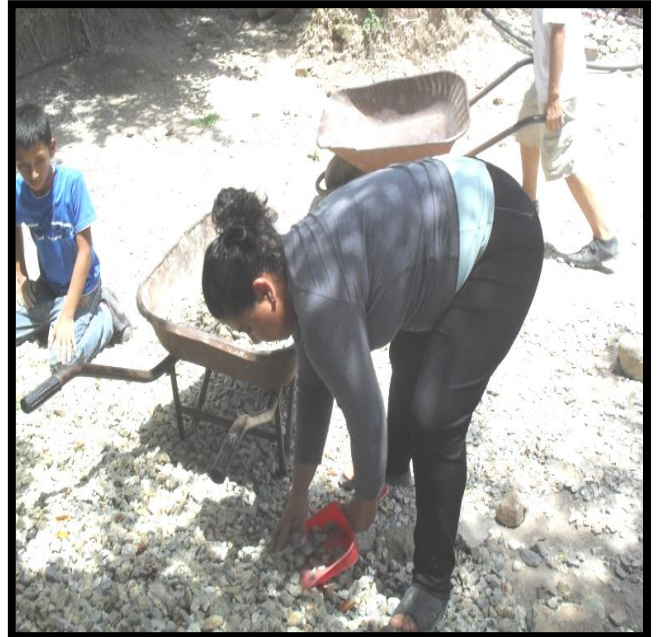
La Epesista trasladando piedrín para rellenar la parte del costado del arriate.
