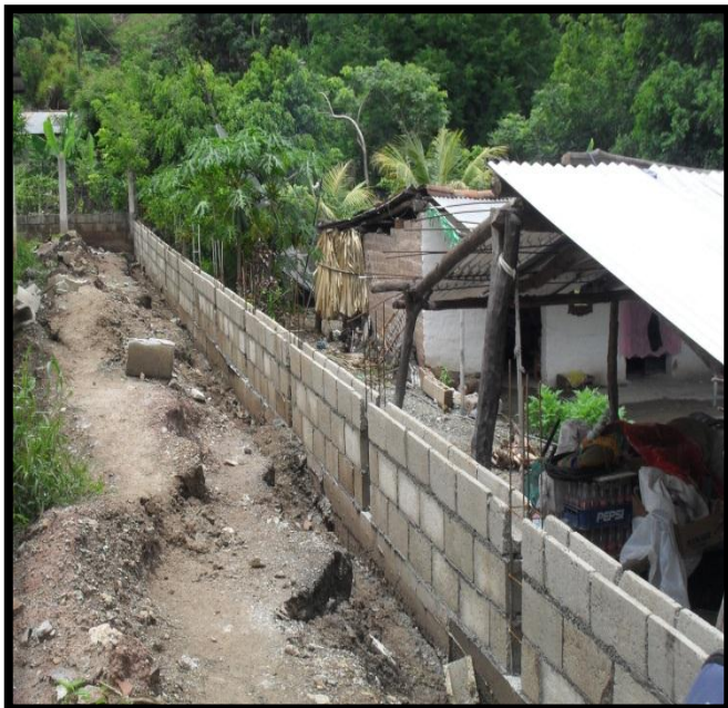
Secuencia de la construcción del muro.
