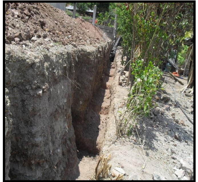
El muro ya desboronado, listo para la construcción.
