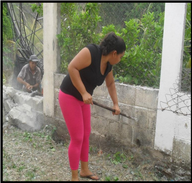
La Epesista desboronando el muro para la construcción del mismo y del jardín.
