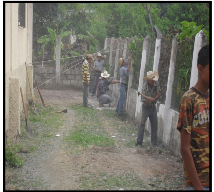
Desboronando el muro para empezar la construcción del mismo.
