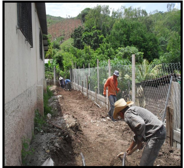
Emparejando el terreno para la construcción del jardín.
