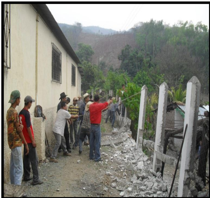
Vecinos de la Comunidad tirando los muros de soporte.
