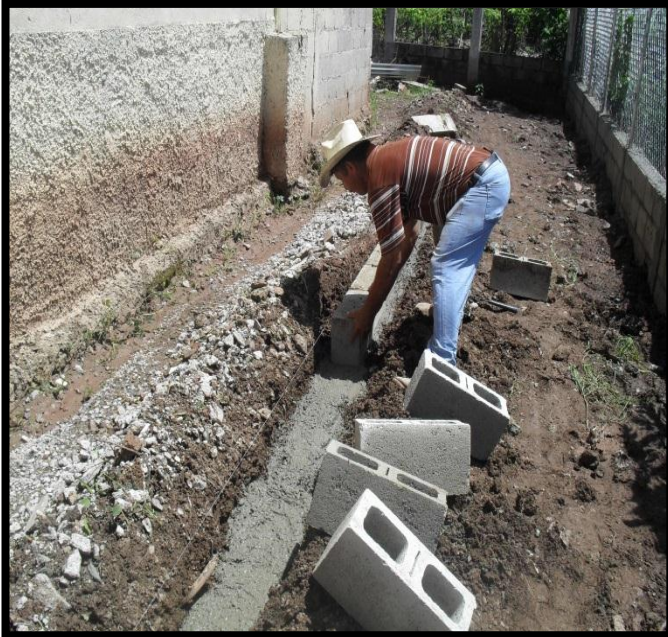
El albañil empezando el arriate para el jardín.
