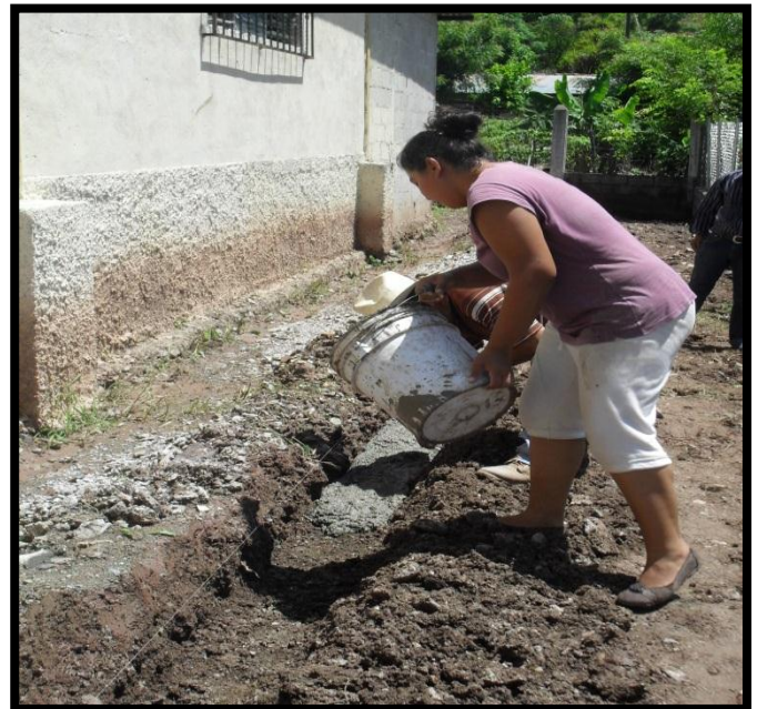
La Epesista pasando concreto para la construcción del arriate.
