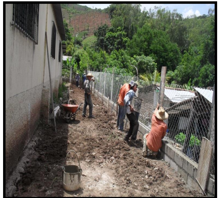
Terminando la construcción del muro para inicio del jardín
