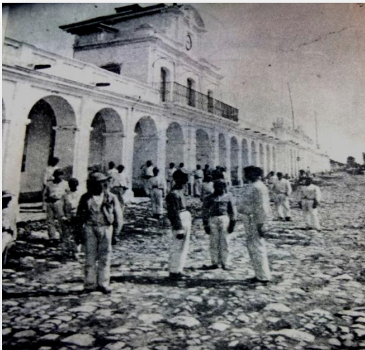
Palacio del Gobierno en la Nueva Guatemala, donde funcionara el Primer Museo, llamado Gabinete de Historia Nacional (1796-1801). Fotografía: E. Muy bridge, hacia 1876. (Lujan Muñoz, 1971)
