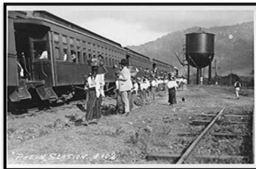
Figura 5. Antigua Estación de Ferrocarril (Fotografía, colección particular, sin fecha) de
