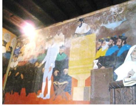
La iluminación de esta área es poca sólo un reflector funciona por lo que no se puede apreciar claramente el mural que tiene desprendimiento de capa pictórica por humedad
