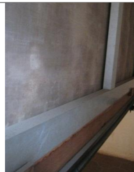
Limpieza realizada del bastidor
