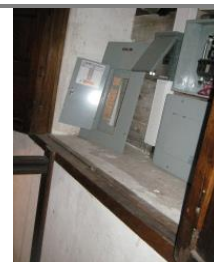
Limpieza realizada en área de conexiones eléctricas.
