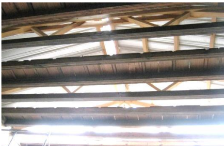
Momento en que se encontraba en proceso de restauración el techo de esta sala
