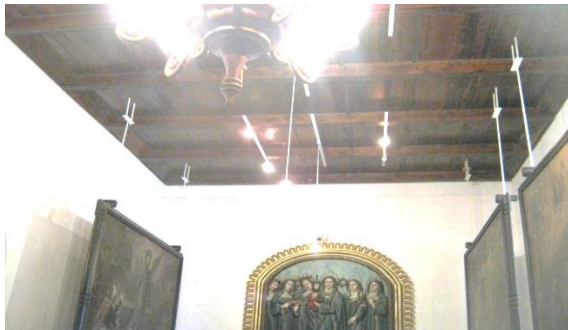
Luz artificial en la sala mediante araña de hierro, madera y plata. Adicional rieles con luces de bombillos alógenos (ojos de buey) que van directos a las pinturas.
