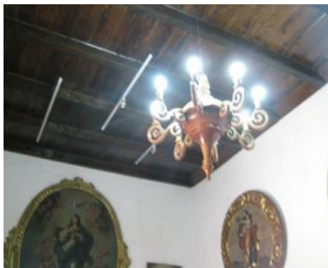
Luz artificial en la sala mediante araña de hierro, madera y plata. Adicional rieles con luces de bombillos alógenos (ojos de buey)
