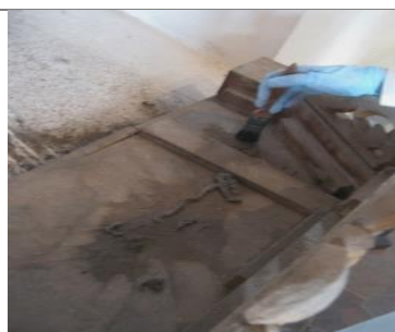
Eliminación de polvo en la superficie del Camerín
