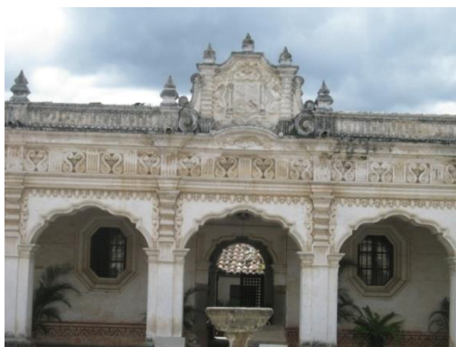
Vista interior del edificio en donde se observa la decoración sobre los arcos y el escudo real en la cornisa meridional. El avance de la humedad en todo el edificio está provocando el desprendimiento de la capa pictórica.
