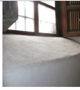
Limpieza efectuada en ventana.
