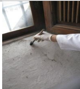
Eliminación de polvo y de telarañas de la ventana
