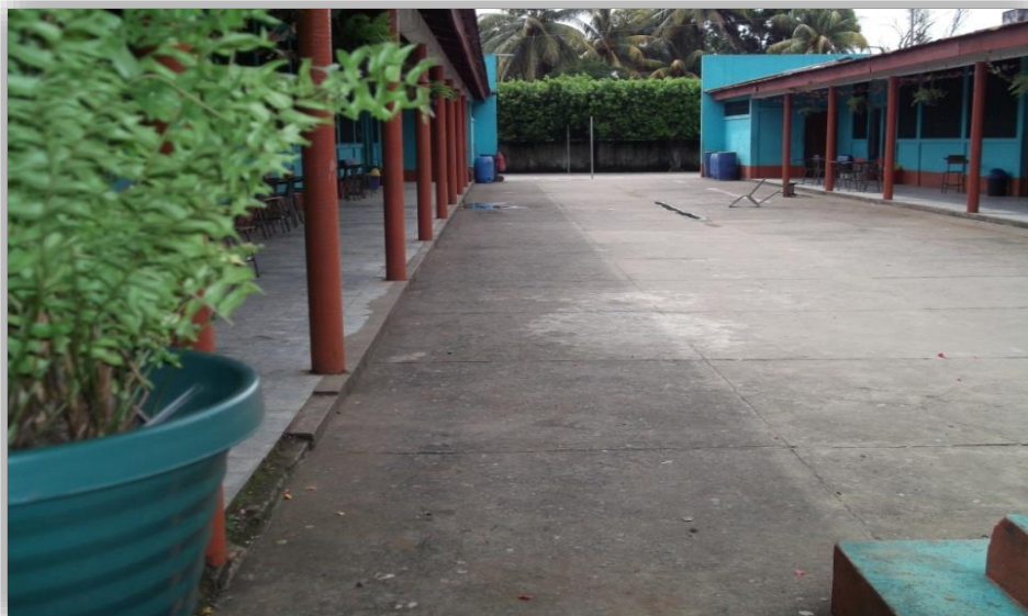
INSTALACIONES DEL INSTITUTO NACIONAL DE EDUCACION DIVERSIFICADA, CATARINA, SAN MARCOS.
