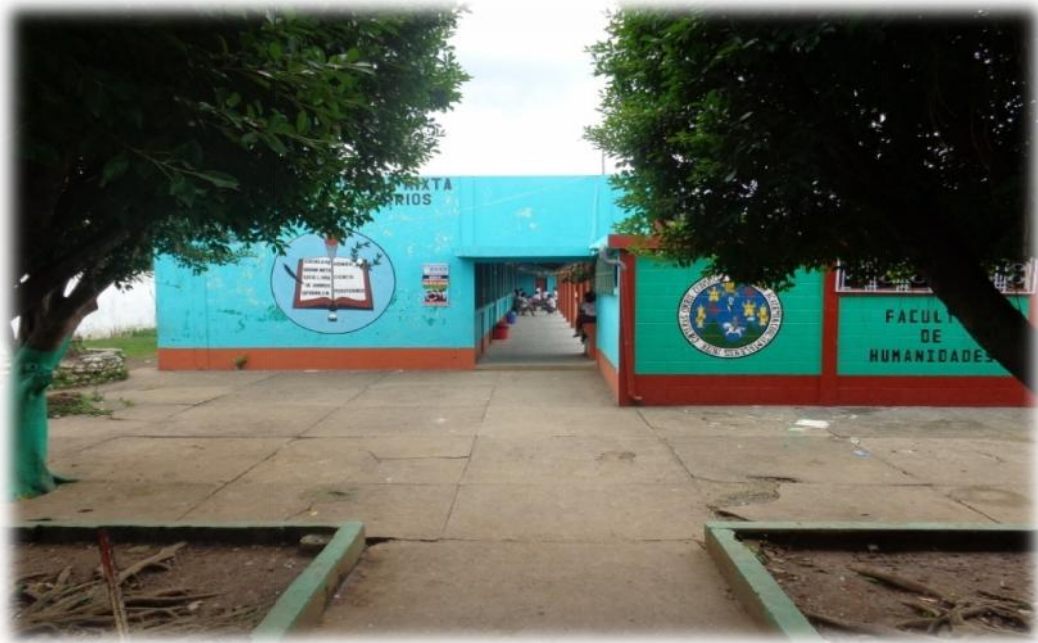
Vista frontal En donde funciona el INED Catarina, San Marcos
