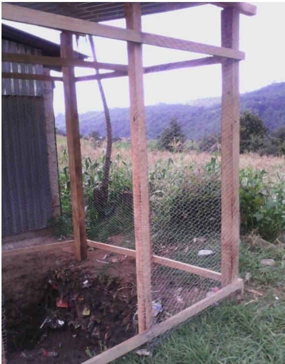
Finalización de la remodelación de la fosa Fotografía tomada por la epesista
