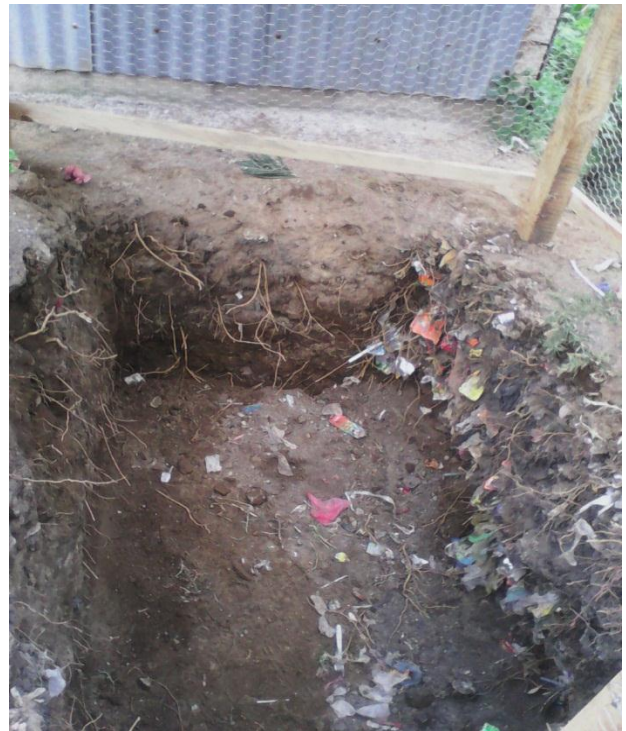
Finalización de la remodelación de la fosa Fotografía tomada por la epesista
