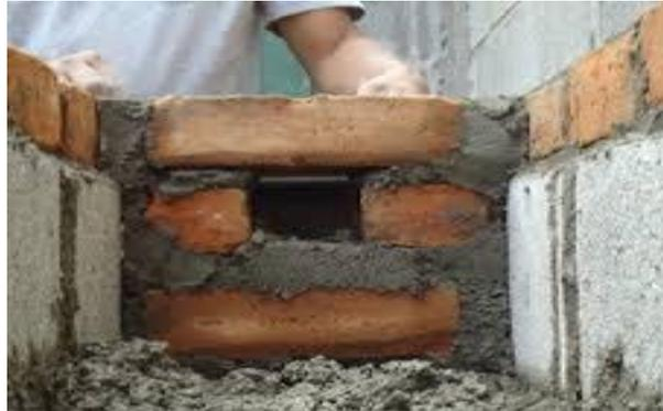
**Paso 3.** Se coloca los blocks con mezcla ya preparada, formando un cajón con la altura de medio metro.
