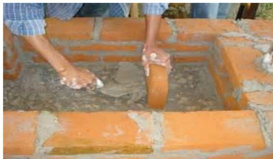
**Paso 5** Cuando la base se seque, se empieza a hacer la caja de fuego. Se coloca la plancha sobre la base, bien centrada y se marca el largo y el ancho.
