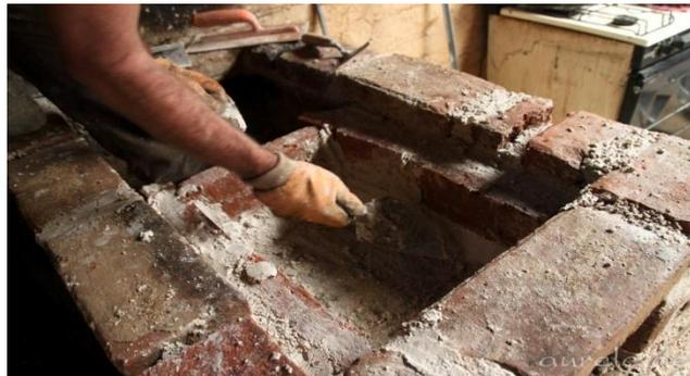
**Paso 4.** Se llena el cajón de blocks con capas de cemento.
