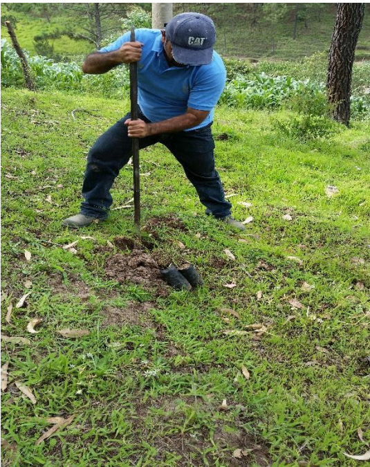
Fotografía de Heidy Girón, 2015. Como segundo paso se perfora la tierra con barreta.
