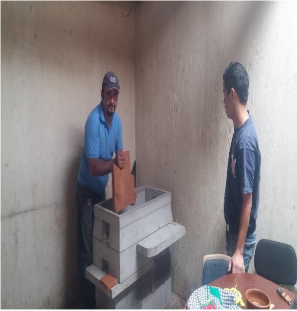
Fotografía de Dony Cabrera, 2015. Colocada la última pieza de cemento y empezando a colocar las de ladrillo.
