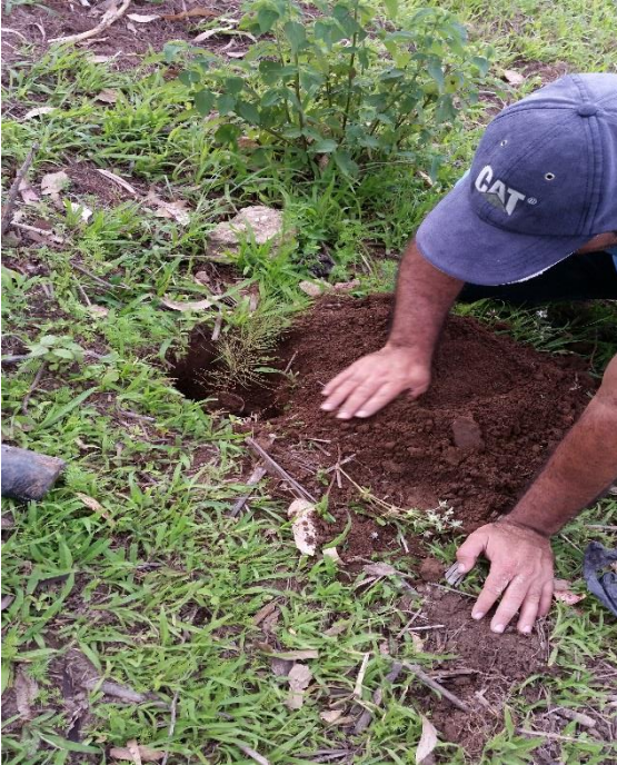
Fotografía de Silvia Hernández, 2015. Como tercer paso, luego de haber perforado lo suficiente, se coloca el pilón en el agujero.
