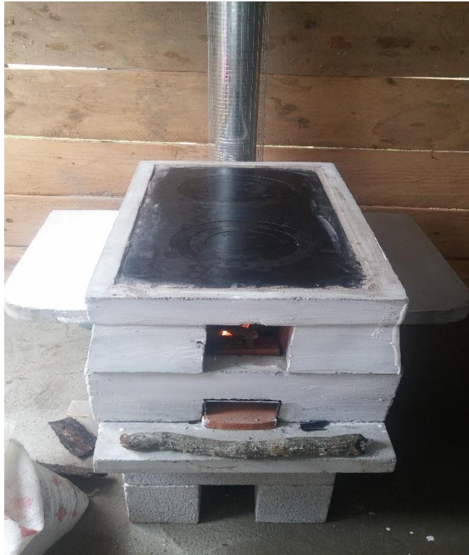
Fotografía de Rigoberto Ortega, 2015. Se coloca la plancha de metal y se arma la chimenea.
