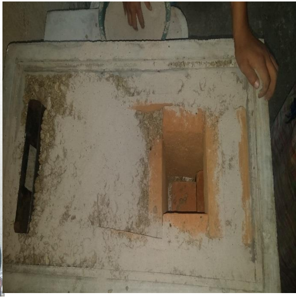
Fotografía de Dony Cabrera, 2015. Colocadas todas las piezas de ladrillo, se rellena de piedra poma, encima la ceniza colada.
