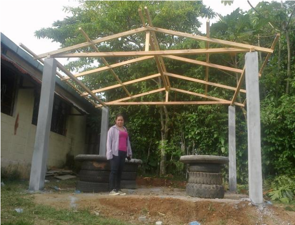
Techado del kiosko.
