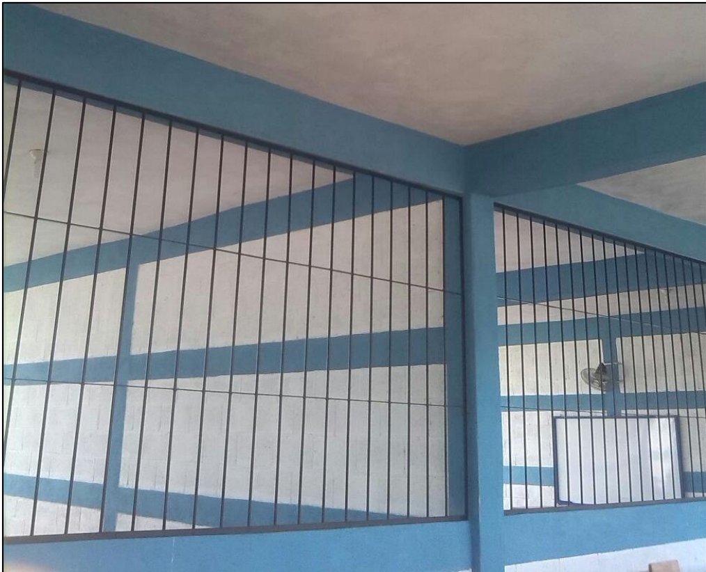
Instalación de balcones en todas las aulas que constituyen el módulo 2 de FAHUSAC Sede Zacapa.
