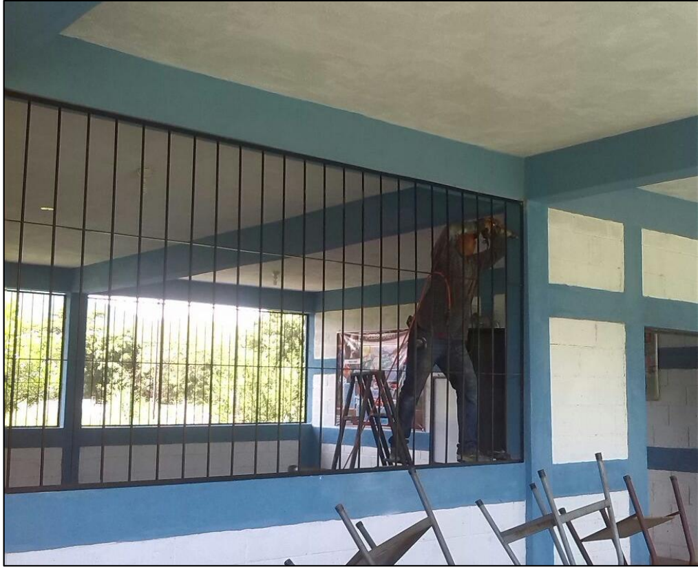
Fotografía tomada durante la instalación de los balcones en el Módulo 2 de la FAHUSAC, Sede Zacapa.
