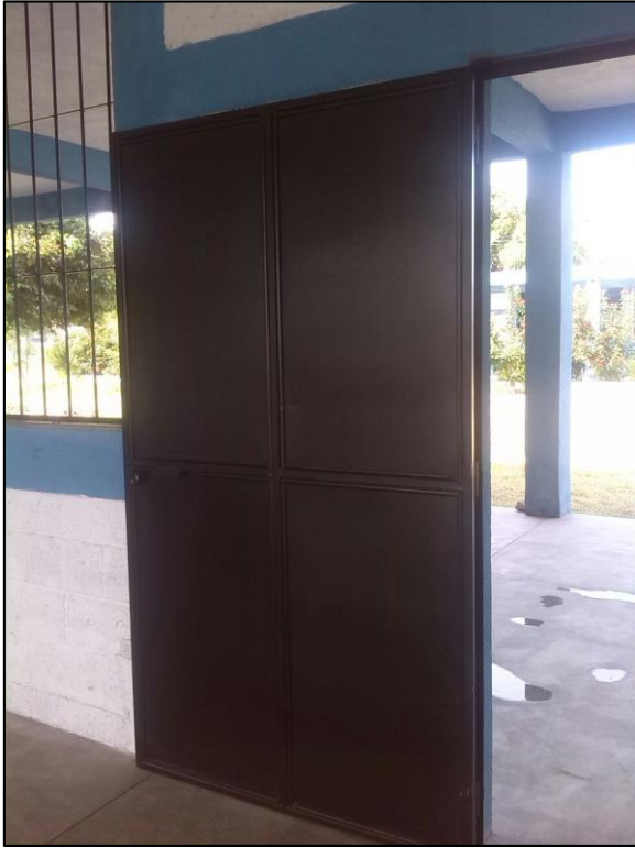
Portones instalados en cada una de las aulas del módulo 2 de la FAHUSAC, Sede Zacapa. (Vista desde el interior de aula No.1)
