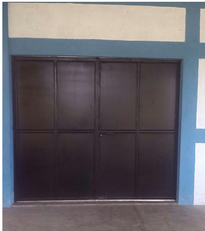
Portones instalados en cada una de las aulas que conforman el módulo 2 de la FAHUSAC, Sede Zacapa.
