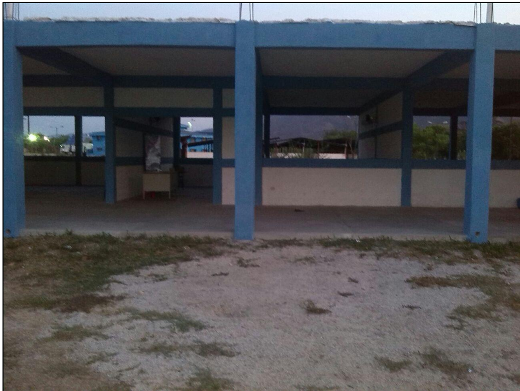
Módulo 2 de La FAHUSAC, Sede Zacapa, antes de la instalación de balcones y portones en cada una de las 5 aulas que lo conforman.
