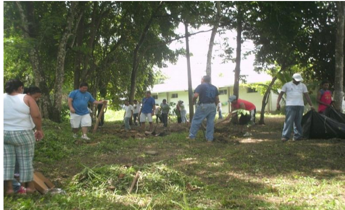
Reconocimiento y Limpieza de Área
