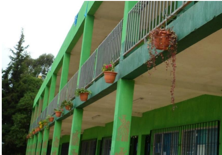
España, M. (Fotógrafa) 2015. No.13. (Fotografía) Colocación de macetas, Santo Domingo Xenacoj, Sac.
