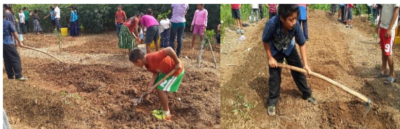
Fotografía tomada por el epesista, alumnos nivelando el terreno para huerto escolar. 2015
