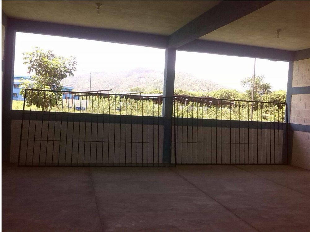
Balcones que se colocarán en las ventanas de las aulas, con el fin de proteger las instalaciones del edificio.
