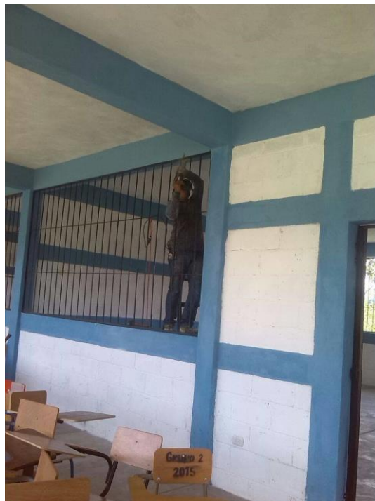
Colocación de balcones en las aulas del edificio de la Facultad de Humanidades, sede Zacapa.
