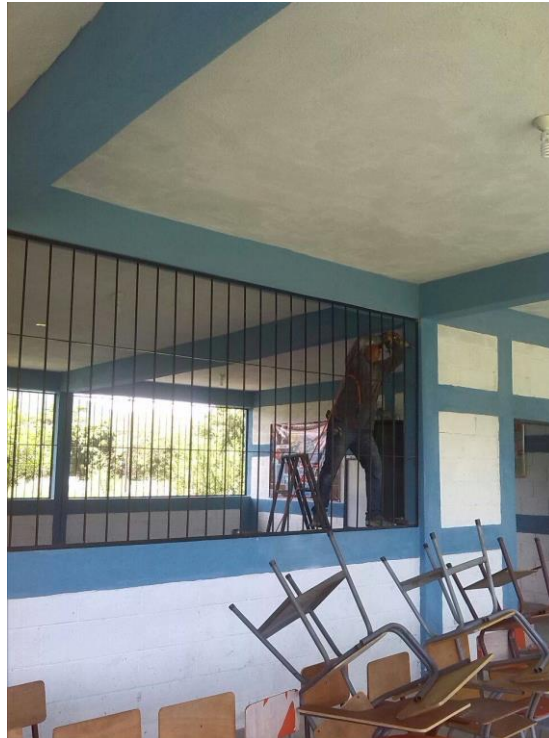
Colocación de balcones en las aulas del edificio de la Facultad de Humanidades, sede Zacapa.
