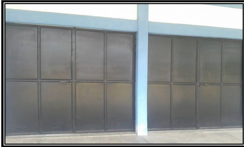
Ya las puertas colocadas en la sede FAHUSAC, Zacapa.
