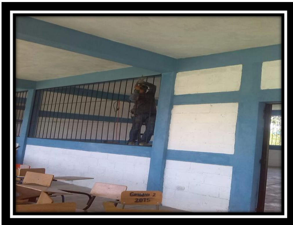
Terminando la colocación de balcones y puertas de la sede FAHUSAC; Zacapa.
