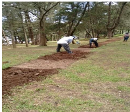
Albañiles realizando la nivelación. Elaboración propia
