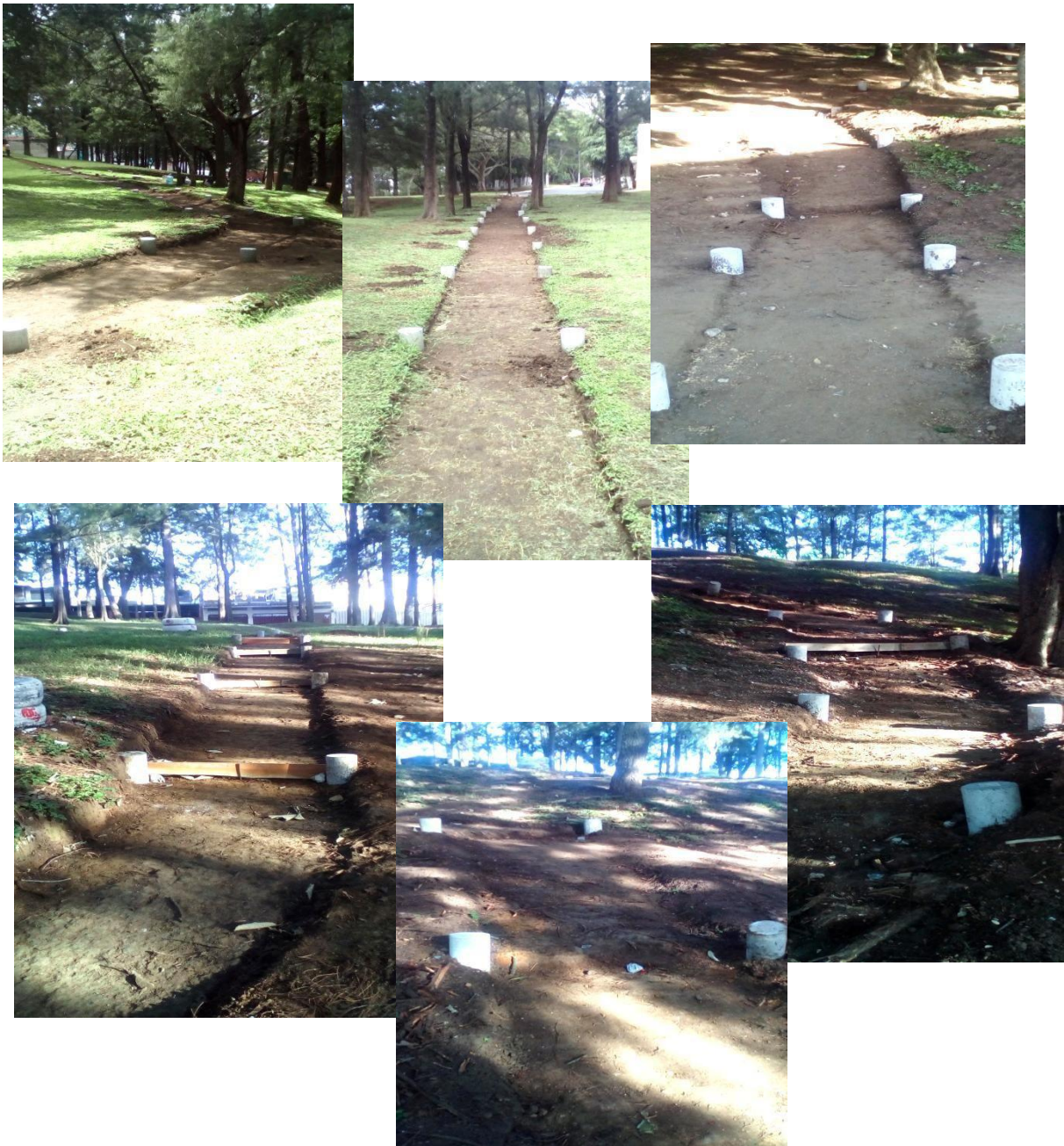
Fotos del encaminamiento en la nivelación, preparación y colocación de tubos de cemento.
