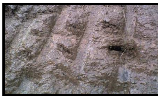
Erosión en Tululché IV. Foto: José Luis
