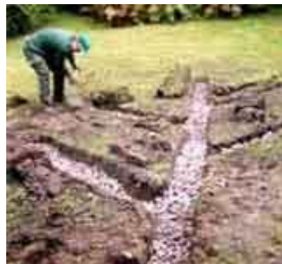
Limpieza del terreno
