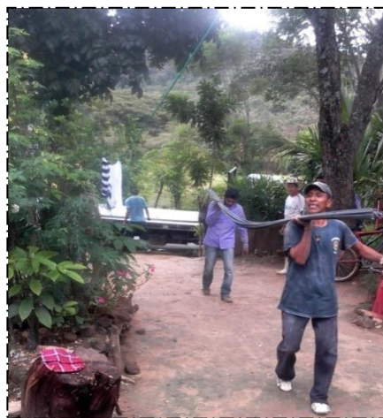
Descarga de materiales para la elaboración del poste
