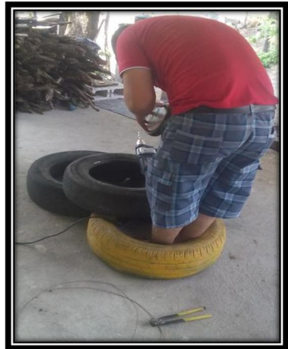
**PASO No. 2** se perforan las llantas para poder sujetarlas con el alambre de amarre.
