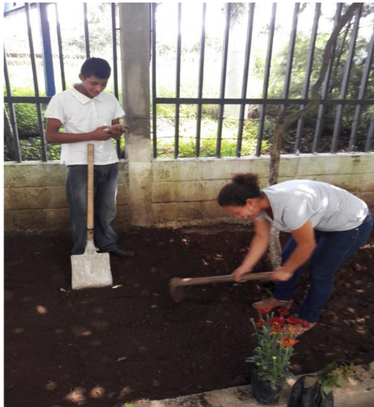
Imagen preparando (limpiando) el terreno a jardinizar
