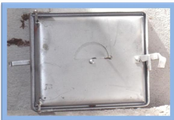
Compuerta de lámina galvanizada
