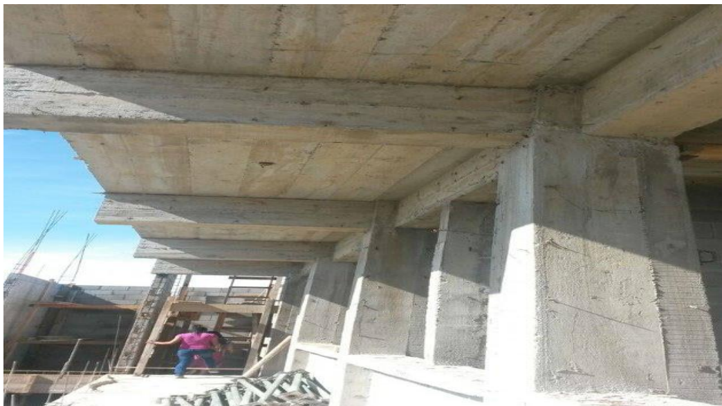
Construcción culminada, dos aulas de la Facultad de Humanidades sección Chimaltenango ya cuenta con techo de losa.
