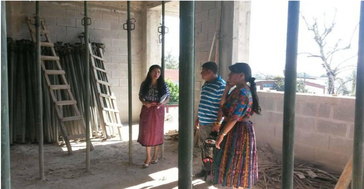
Epesistas evaluando la culminación de fundición del tercer nivel.
