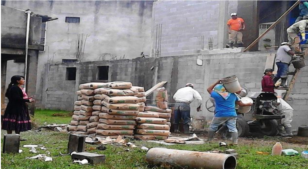
Supervisión de la construcción por parte de la Directiva de Epesista.
