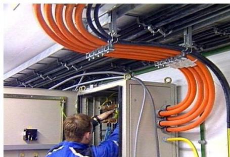
**3) Instalaciones parcialmente ocultas.** Son instalaciones entubadas en las que una parte está empotrada en pisos, paredes y columnas, y la restante es visible y va escondida entre armaduras o falso plafón.
