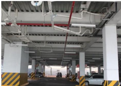
**2) Instalaciones visibles entubadas.** En estas instalaciones sus partes componentes se encuentran a la vista, pero protegidas con tuberías, cajas de conexión o dispositivo de unión, control y protección
