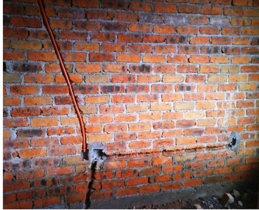
**4) Instalaciones ocultas.** Son instalaciones entubadas que están totalmente empotradas en pisos, paredes, columnas y techos, y solo son visibles en los dispositivos de control y protección.
