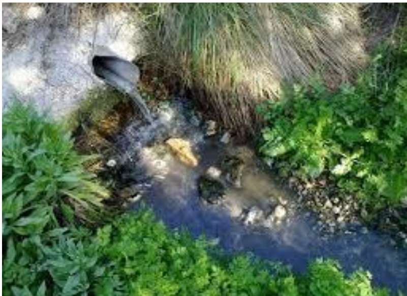
VIVIENDA CON AGUAS SERVIDAS EN EL PATIO DE LA CASA.
