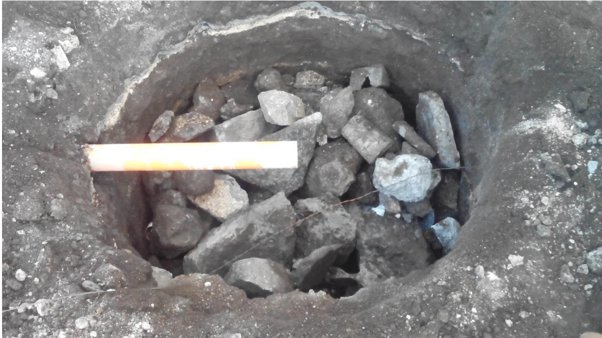
Culminación del pozo de absorción para aguas residuales
