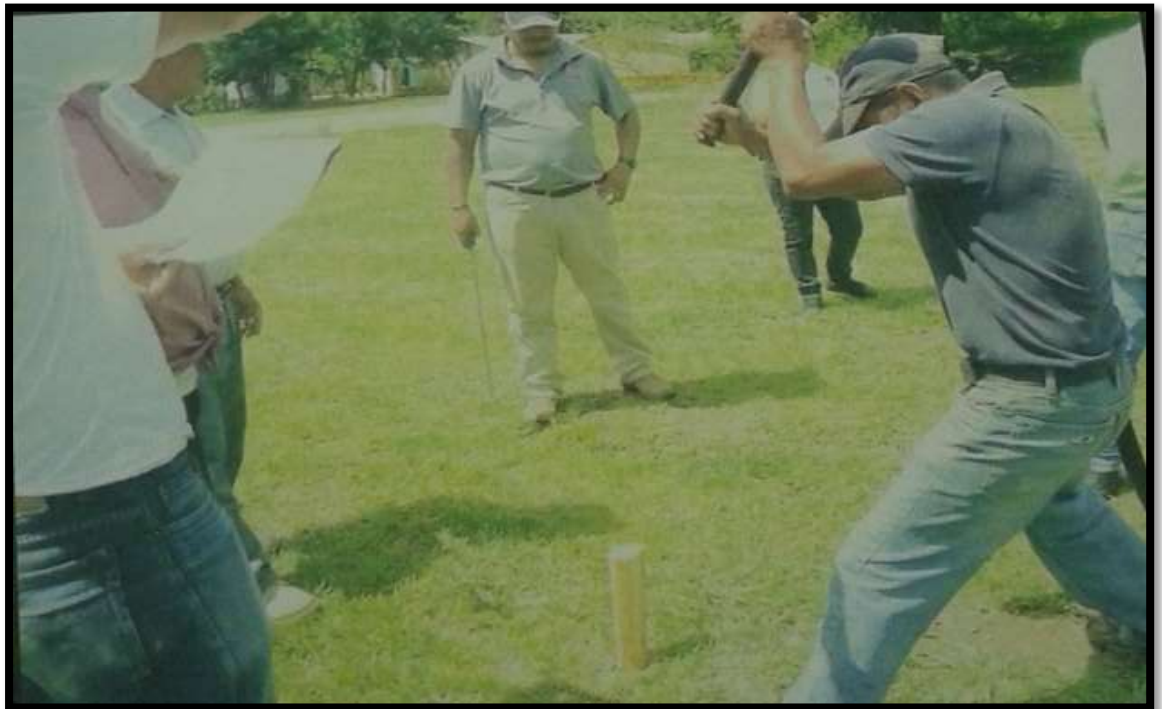
Realizando la limpieza y estaqueado del terreno.
