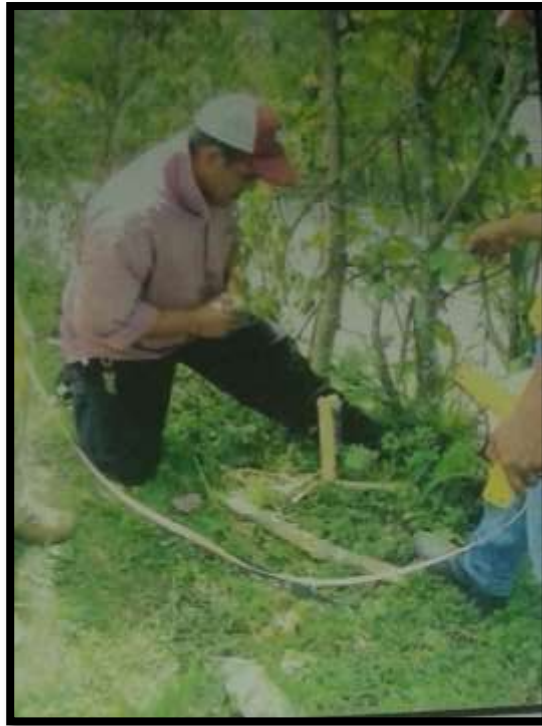
Colocando las estacas, con las medidas exactas del terreno.
